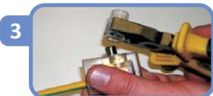
**Fig.1:** Utilizzate **DOXY** come un normale morsetto di giunzione.
