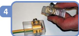
**Fig.2 :**Per sicurezza controllare che il grano del morsetto **DOXY** già installato sia ben fissato, stringere nuovamente il grano se necessario. Con una pinza Bloccare il canotto del morsetto **DOXY** già installato, facendo attenzione a posizionare la pinza il più vicino possibile al corpo isolante. Ruotare nel senso d'avvitamento del grano la pinza mantenendo la pressione sul canotto.
